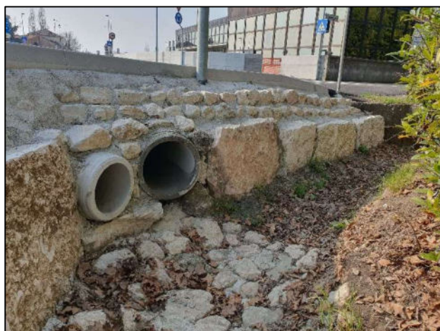
Figura 15: dettaglio dello scarico della fognatura sul Rio la Rosta
