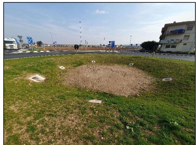
Figura 14: depressione per la laminazione delle portate all'interno della rotonda all'ingresso di Moriago venendo da Sernaglia
