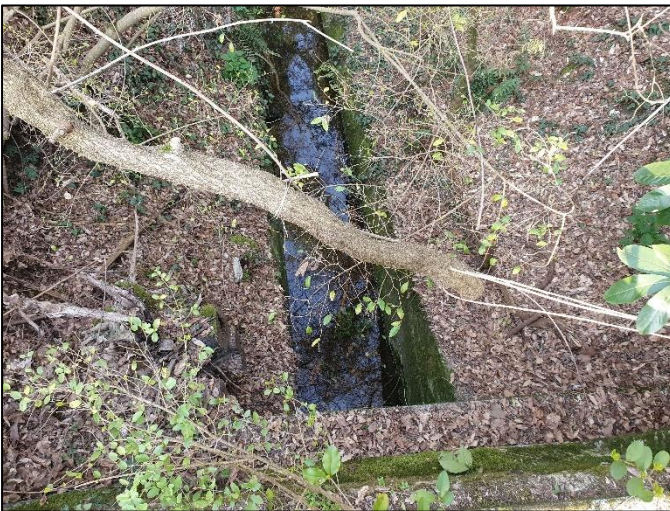
Figura 24: vista dall'alto dello scarico della fognatura verso il torrente Raboso
