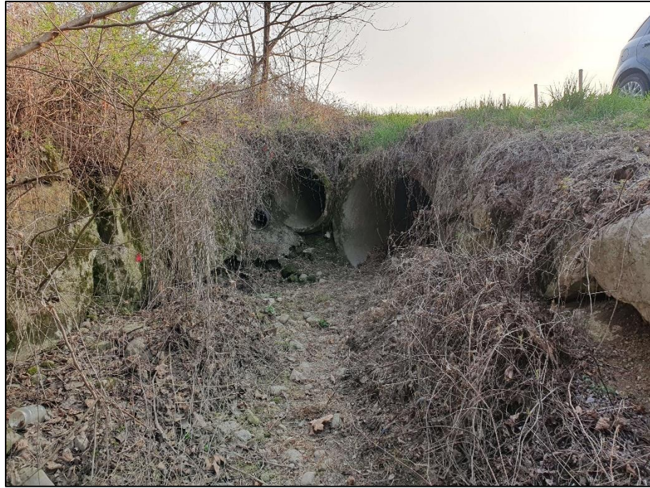
Figura 42: sezione di chiusura del sottobacino SB1R-a in cui si possono osservare la condotta del canale tombinato (sulla destra) e il tratto terminale della fognatura (sulla sinistra)
