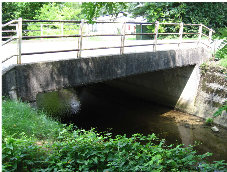
Foto 9 – Ponte di Via Raboso sul Rosper
