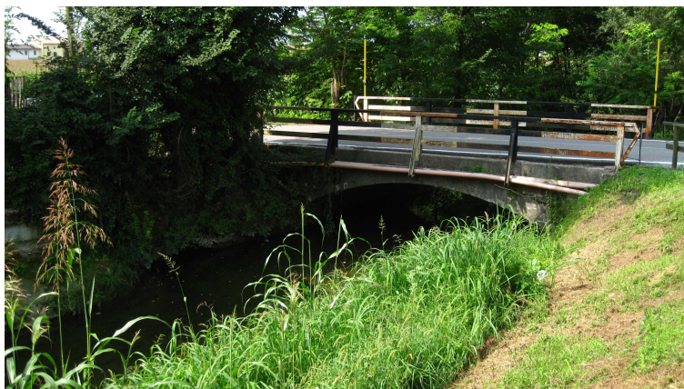
Foto 4 – Ponte di via degli argini sul Rosper
