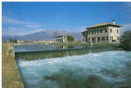
Contemporaneamente, anche per l'area di destra Piave, venne realizzata una presa che alimentava il canale della Vittoria, dal quale si sono sviluppati poi numerosi canali irrigui secondari.
