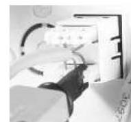
Le suddette prese dovranno essere montate tramite appositi adattatori sui contenitori e prese delle principali serie civile dal lato posto di lavoro e sui patch pannel sul lato rack. Non sono ammessi l'utilizzo di connettori di marca diversa dal lato utente al lato rack dati. La sequenza di attestazione potrà essere quella di tipo T568A o T568B, riportata sul frutto con codice colore per entrambe le tipologie.
