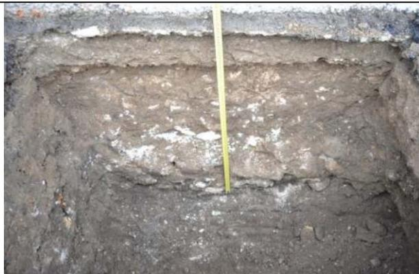
**Figura 33 - saggio sulle fondazioni**
